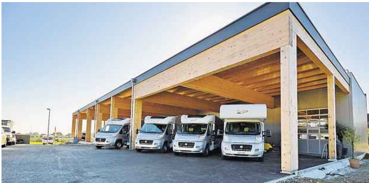
Das grosse Holzvordach bietet 24 Fahrzeugen Platz und gibt dem Bau einen überzeugenden Gesamteindruck.
